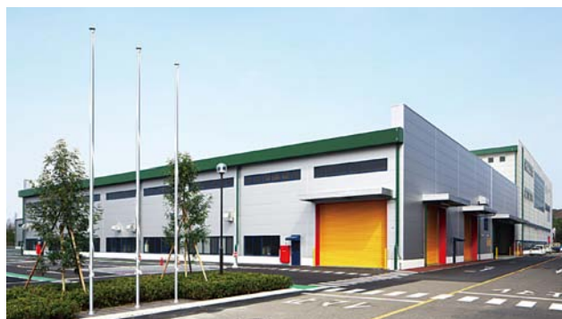
昨年末に完成した暁第一工場内の板金専用工場
