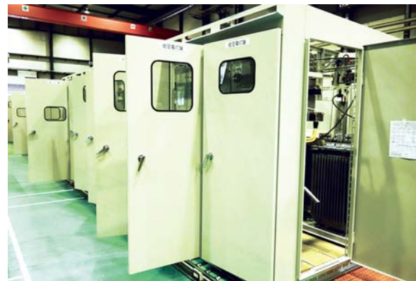
電装組込中のキュービクル
