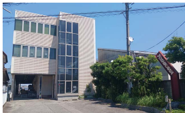
吉河エレックス(株)の日進工場。同社はトランス製造を行う「名西工場」、板金加工を行う「日進工場」、組立を行う「名古屋工場」の3つの製造拠点を持つ
