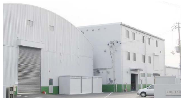
2016年に建設・移転した小林精工株の新工場
