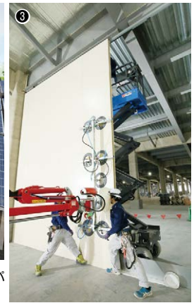
①飛沫感染防止対策で生まれたクリアパーテーションはすでに2万台以上を販売した／②産業用ソーラーカーポート／③耐火パネル、不燃パネル、不燃断熱パネルを使った物流倉庫のパネル設置工事
