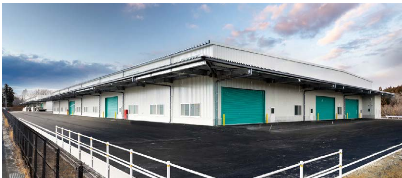
2022年4月に稼働開始する福島第2工場
