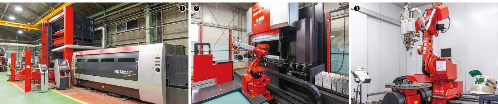
①省エネとDXの促進を目的に導入されたファイバーレーザーマシンFLC-2412AJ+ASFH-2412 / ②ベンディングロボットシステムEG-6013AR+EGROBOT。自動化マシンやロボットを活用することで使用電力量を平準化する / ③ファイバーレーザー溶接システムFLW-3000ENSIS
