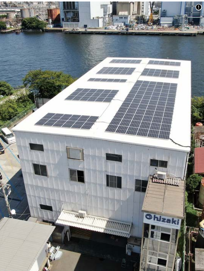
①工場屋根に設置した自家消費型の太陽光発電パネル(163枚・発電容量50kW) / ②③2020年9月に導入したファイバーレーザーマシンENSIS-3015 RIと、2019年3月に導入したファイバーレーザー複合マシンLC-2515 C 1 AJ。生産性向上と電力消費量の低減に貢献している
