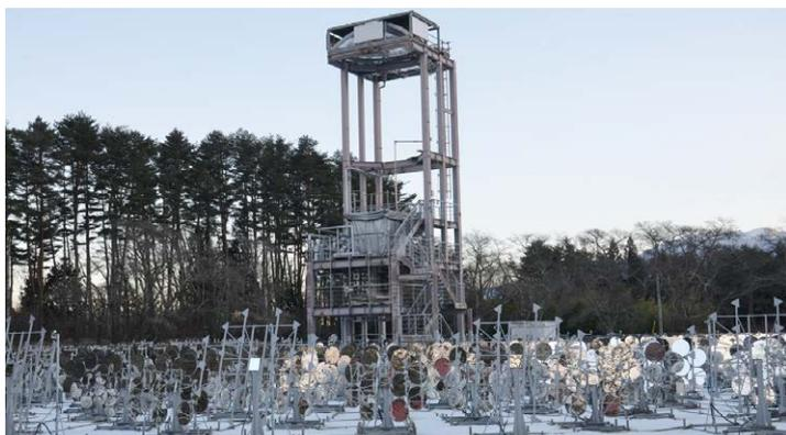
太陽熱発電の太陽追尾型ビームダウン方式のヘリオスタット(反射鏡)
