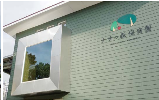
園舎2階の多目的ホールには、同社のスタッフが製作したステンレス製の出窓がつくられている
