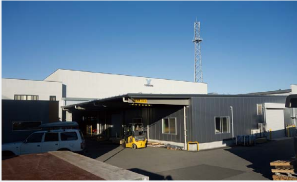
長野県上田市にある(株)吉見鋳金製作所
