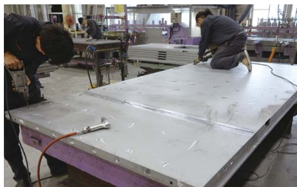
大型ドアの溶接作業
