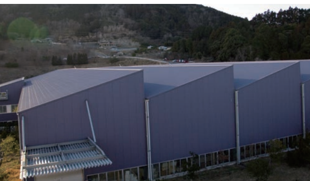
太陽光発電パネルの設置を考え、工場建屋の屋根は真南に向け最適な角度にしている
