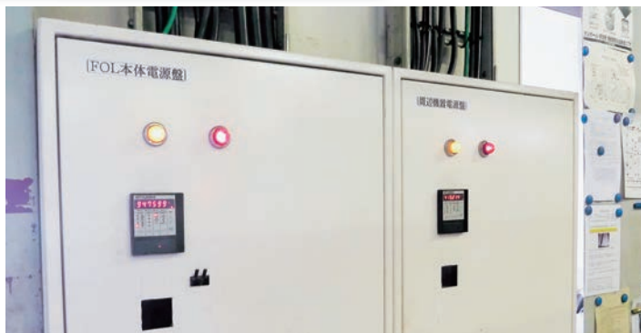
FOL-AJの電源部にはパワーメーターが取り付けられ、リアルタイムで使用電力量をモニターできる
