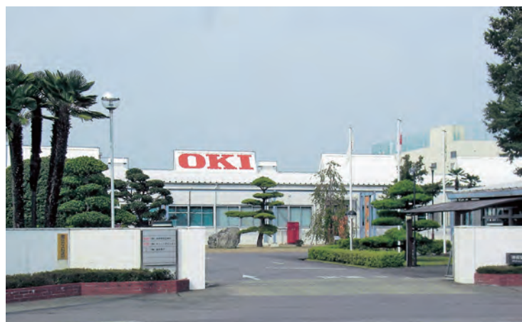
群馬県富岡市にある沖電気工業(株)メカトロシステム工場
