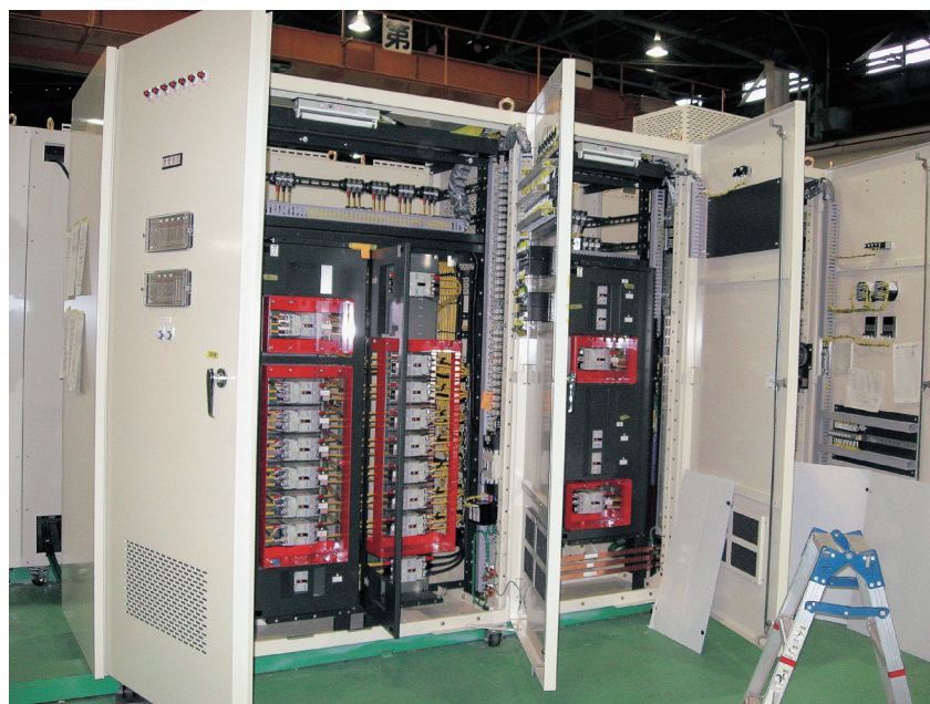
筐体の中にブレーカーや基板、各種スイッチが組立配線される
