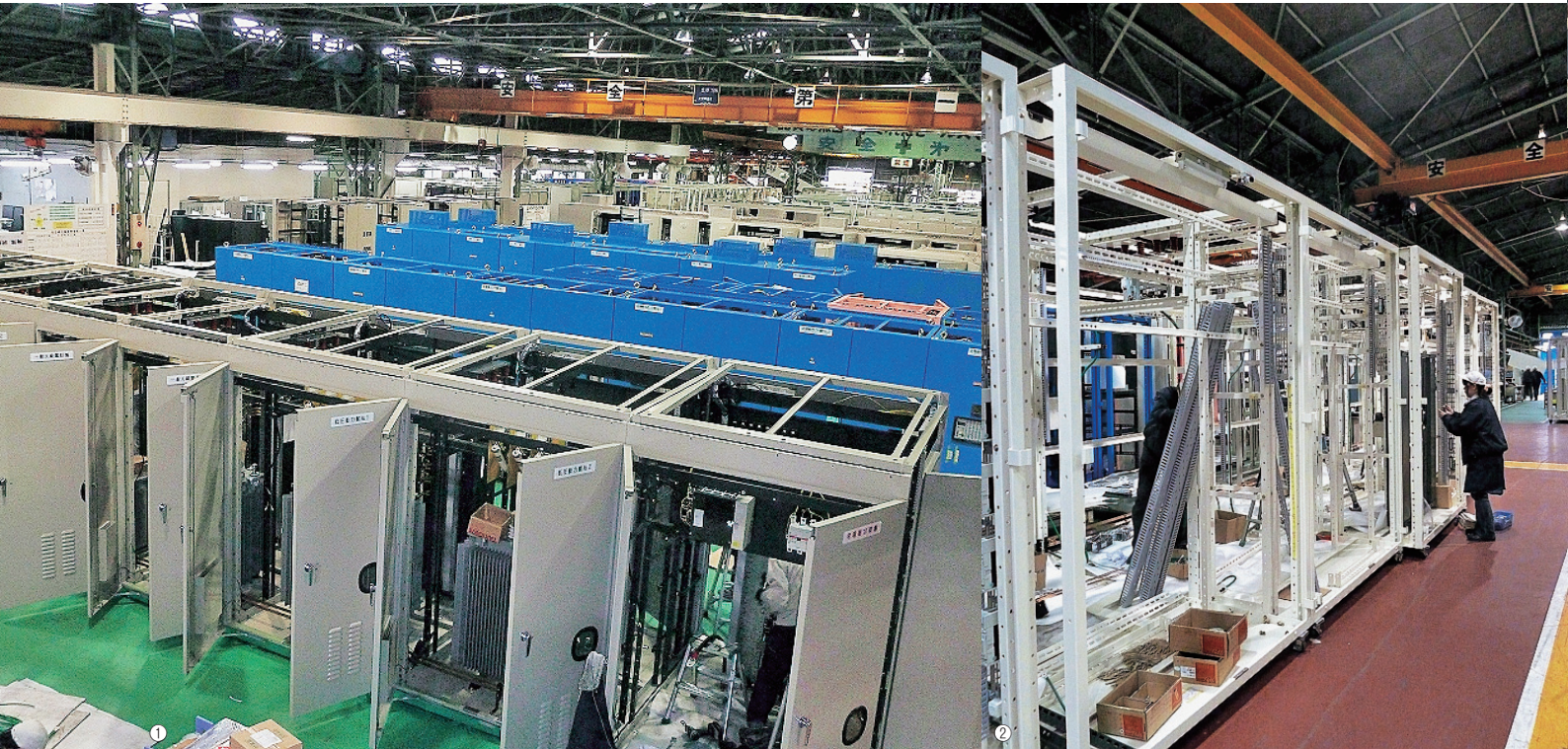
①組立工場では物件対応の各種盤が組み立てられている ②筐体のフレームに取り付けられた機器にシールを貼る作業
