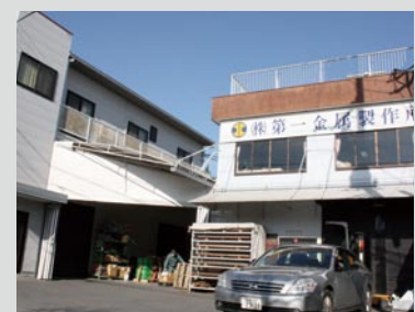
(株)第一金属製作所 工場外観。
