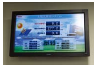
太陽電池によって自家発電された電力量と現在使用中の電力量、自家発電でまかなっている割合が工場内に表示され環境対策にも力を入れる。
