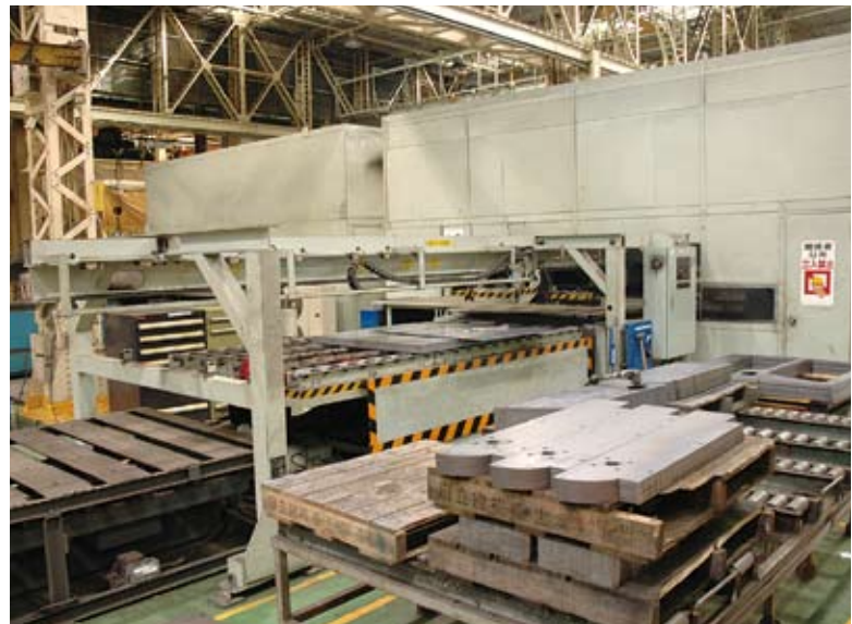
COMA-567 2台がサイクルローダー ASR-510CRとL/UL-510セル化され消音ボックスに格納されて稼働している
