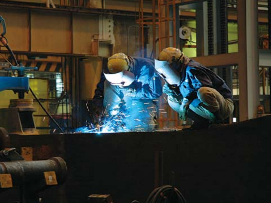
製缶構造物の溶接
